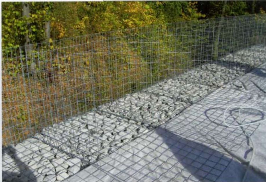
Les gabions ont été remplis de galets de 60 à 150 mm disposés en vrac, à l'exception de leur partie haute, pour en soigner l'esthétique et en optimiser le remplissage.
