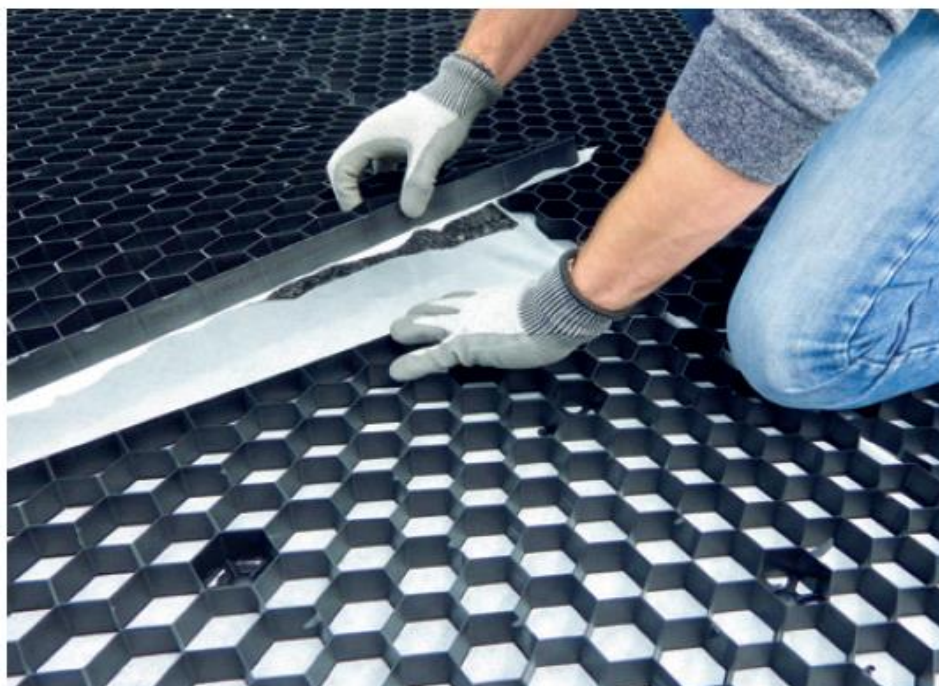
Pour une entrée de garage ou un parking avec un passage de véhicules, Nidaplast commercialise le Nidagravel 140, d'une épaisseur de 4 cm. Sa résistance en compression est plus importante, de l'ordre de 400t/m 2 .
