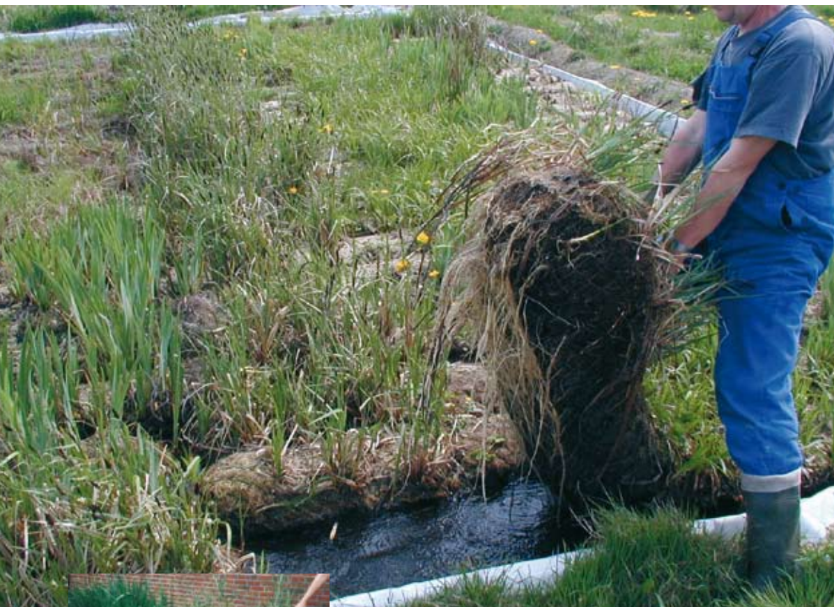
Géonattes et fascines d'hélophytes pré-végétalisées, avec un système racinaire développé et bien visible.
